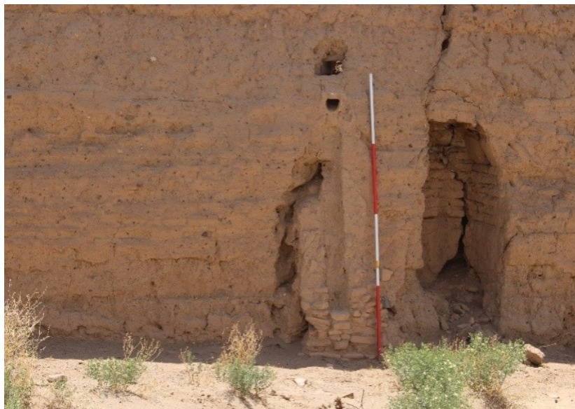
عکس ۲۱- کار گذاشتن تنبوشه سفالی در دیوار آسیاب برای انتقال آب باران از روی مجموعه ساختمانی قسمت غربی آسیاب و هدایت آن به خارج از آسیاب (نگارندگان: ۱۳۹۷)
