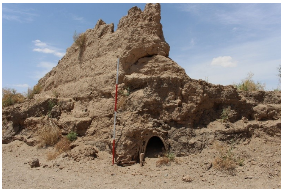
عکس ۱۳- کانال خروج آب از آسیاب در قسمت شرقی دیوار دفاعی آسیاب (نگارندگان، ۱۳۹۷)
