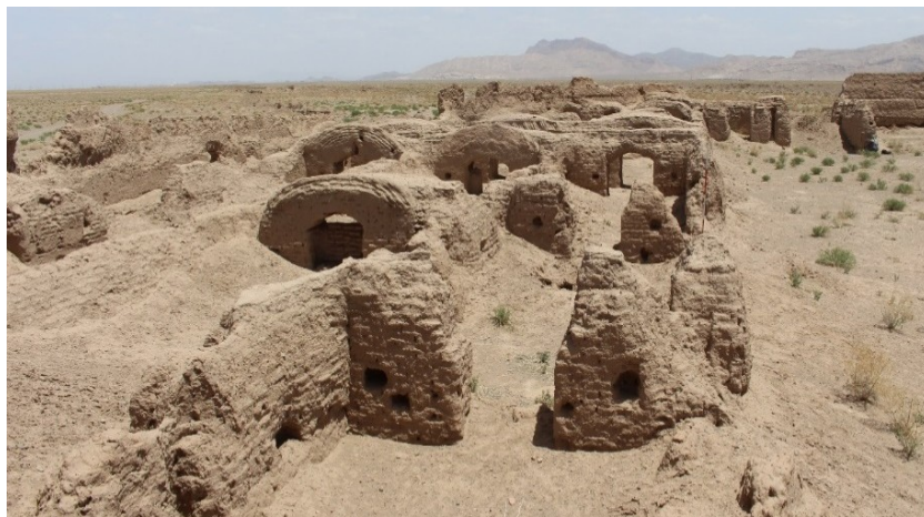
عکس ۱۸- مجموعه ساختمانی در قسمت غربی مجموعه آسیاب دید از جنوب (نگارندگان، ۱۳۹۷)
