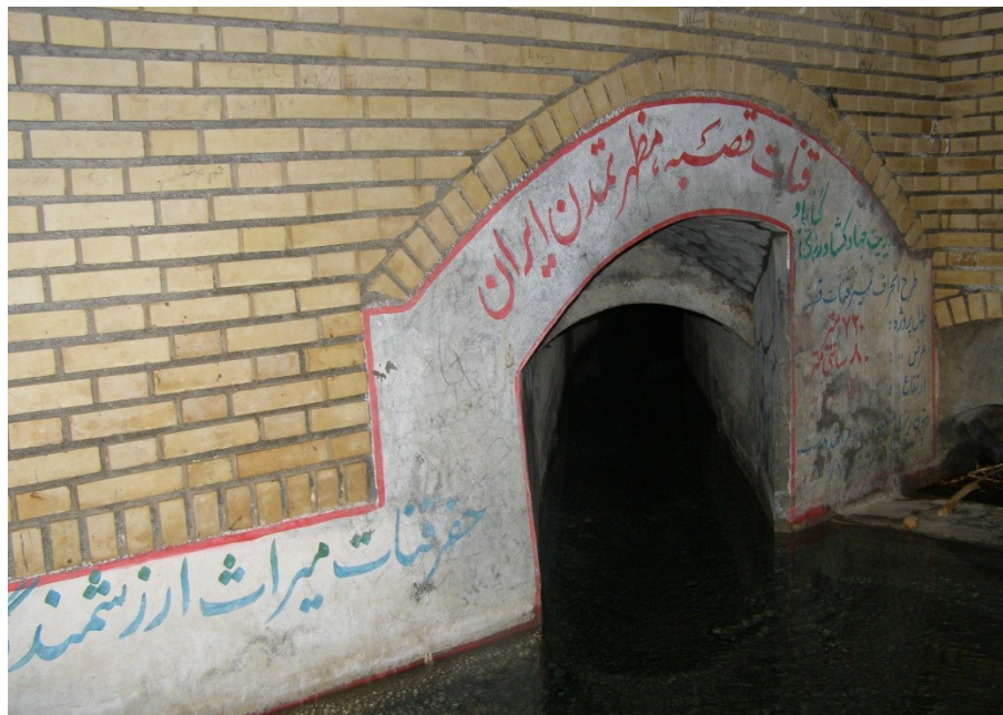
عکس ۱- نمایی از مظهر کاریز قصبه گناباد (ساکماق، بی تا: ۱۰۱۲۷۲).
