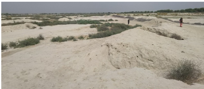
عکس ۳- نمونه‌ای از سازه دگار در جنوب روستای رانک، ساخته‌شده برای بهره‌برداری از سیلاب (منبع: نگارندگان)
