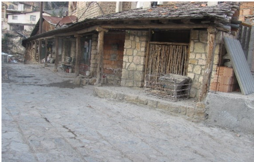
عکس ۱۲- اجرای تخته سر در پوشش بام
