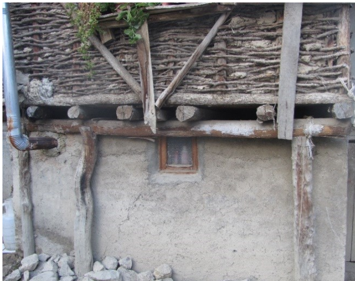
عکس ۸- نمونه‌ای از تیرهای دوش‌کش بالای ستون‌های دِخال در طبقه اول
