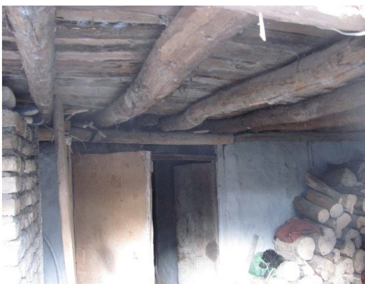
عکس ۹- اجرای تیرهای نشیمن در سقف طبقه اول
