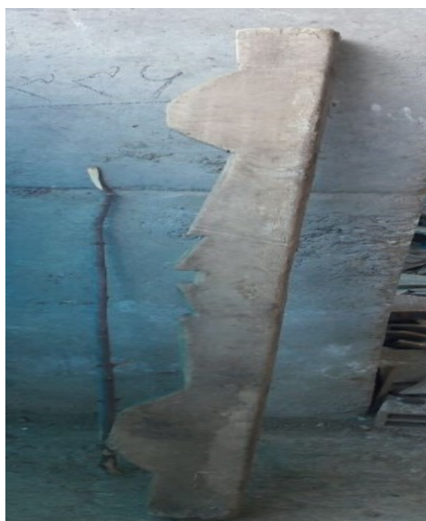
عکس ۶- نمونه‌ای از چوب جفت و سم چوب
